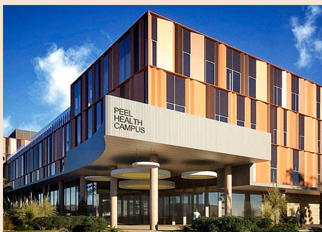
El nuevo complejo se construirá en el actual campus de la salud de Peel.
